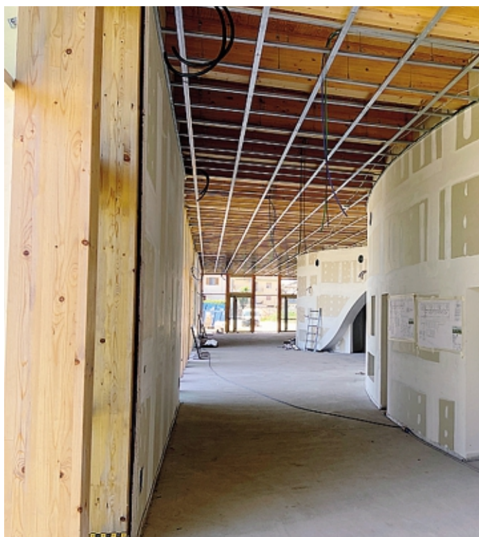
Il sopralluogo alla scuola materna di Massalengo Dovera
