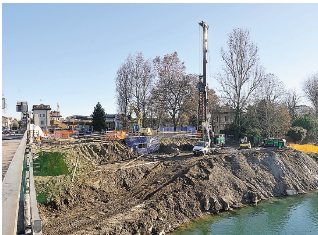
Gli interventi preliminari per i lavori sul ponte dell'Adda foto di Paolo Ribolini
