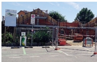
Sordio: lavori in corso Cornalba
