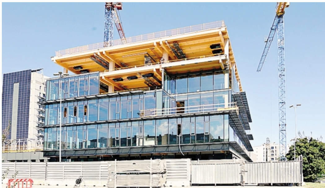
Il cantiere avviato da tempo per la realizzazione del nuovo quartier generale del colosso informatico Zucchetti
