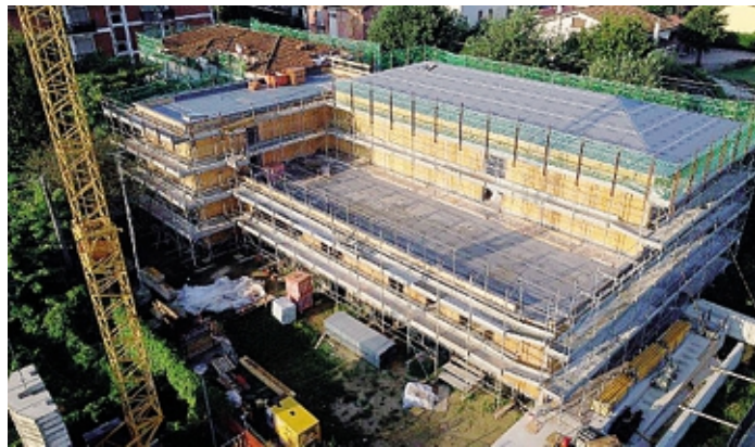
Il cantiere della nuova scuola a Castelgerundo
