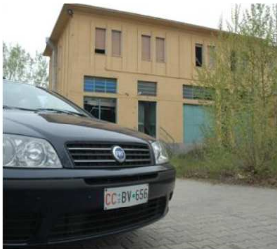
EX FABBRICA Al 2008 risale la prima operazione dei carabinieri sul posto
